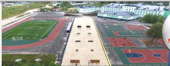
Работы по благоустройству завершены в сентябре 2025 года Площадь территории: 23,1 тыс. м 2
